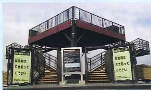
津波避難タワー
