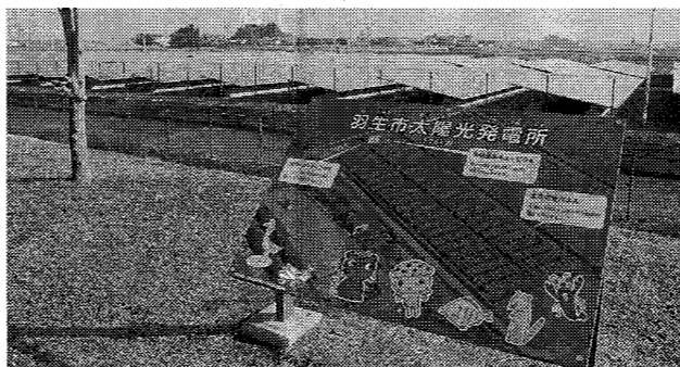
羽生市下村君太陽光発電所
